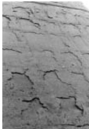
**Figura A.5** Mapa de fisuras siguiendo la cuadrícula de armado, debido a la carbonatación del recubrimiento.
