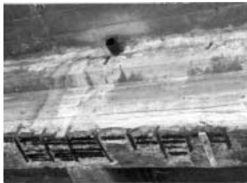
**Figura A.6** Saltado del recubrimiento debido a corrosión generalizada por carbonatación.
