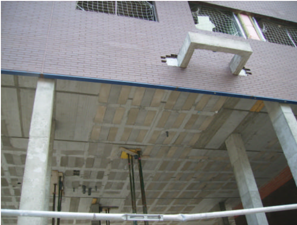
Foto 4. Forjado reticular de bovedilla de hormigón del edificio.
