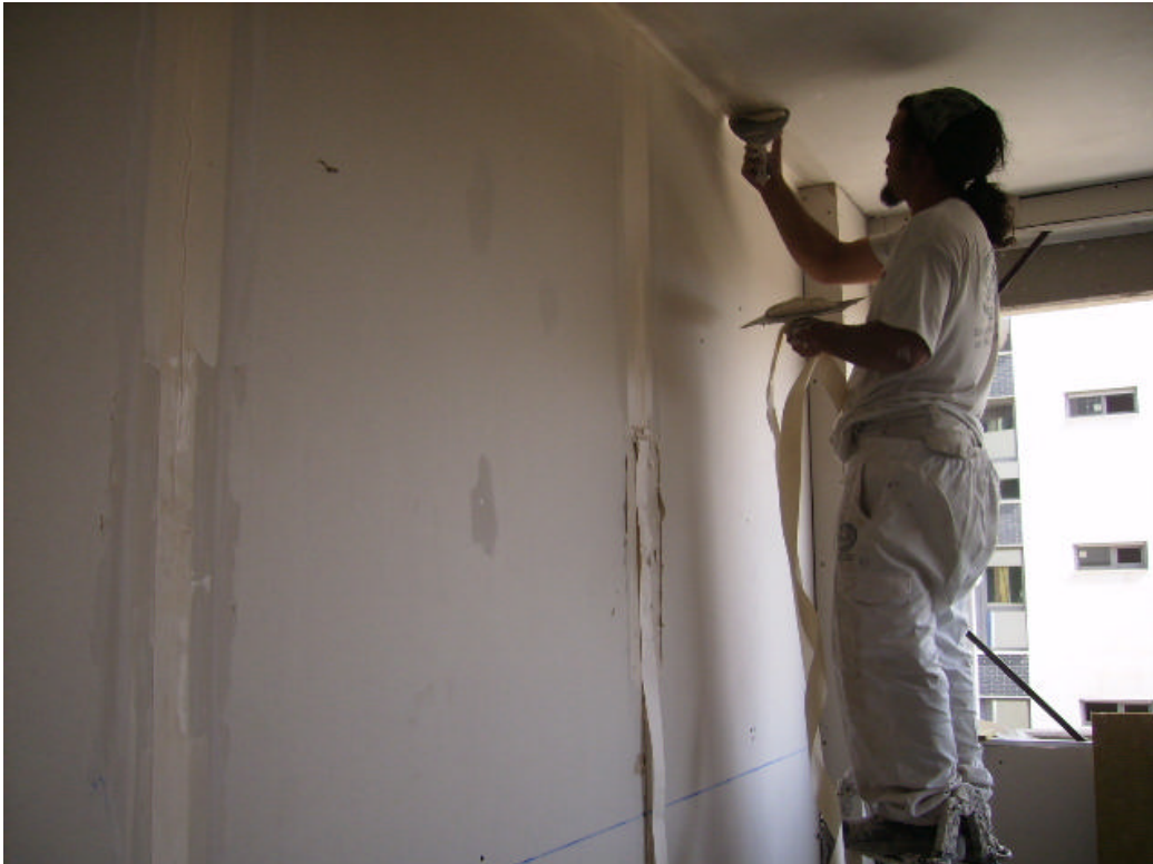
Foto 16: Ejecución de acabados de sistemas y trasdosados de de PYL entre distinto usuario.
