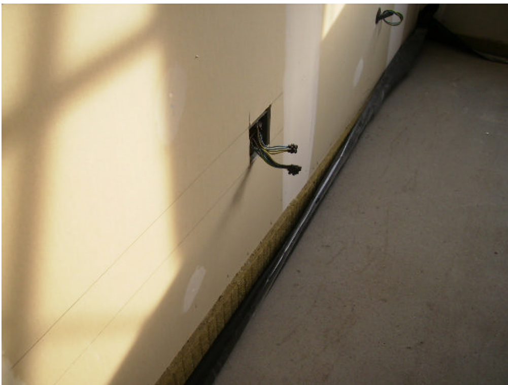
Foto 23: Preparación de suelos para suelo flotante. Acabado perimetral una vez ejecutada la solera.
