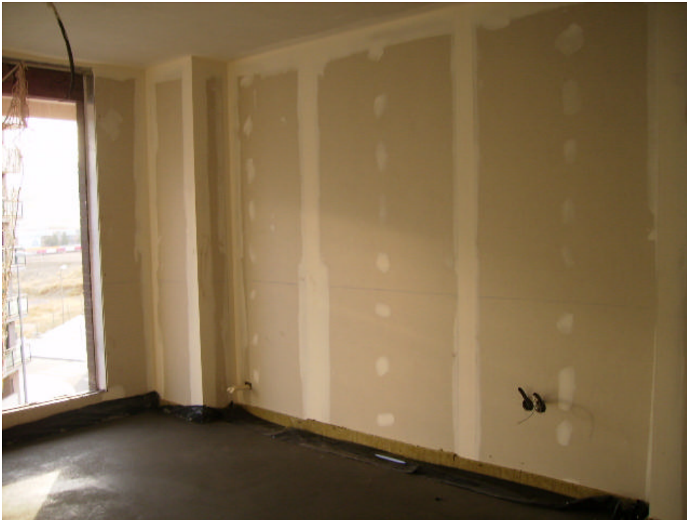
Foto 22: Preparación de suelos para suelo flotante. Instalación de un plástico sobre la lana mineral.
