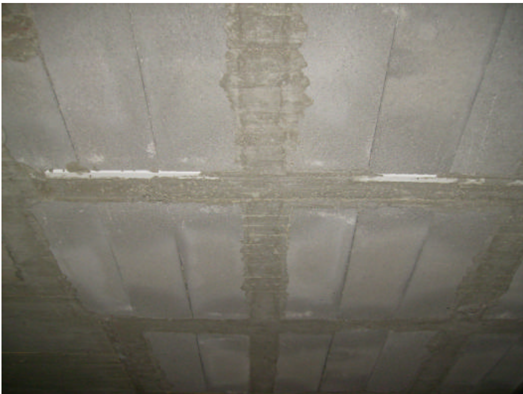
Foto 5. Forjado reticular de bovedilla de hormigón en las habitaciones.
