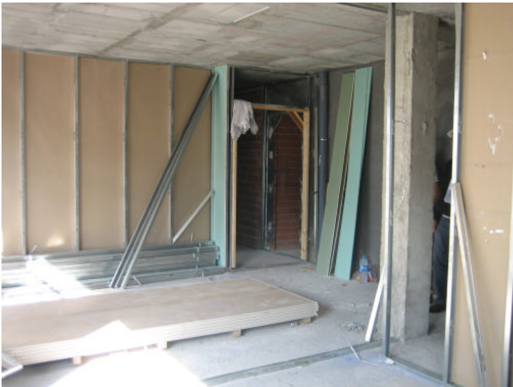
Foto 11: Preparación de la perfilería para divisiones en PYL de distinto usuario.
