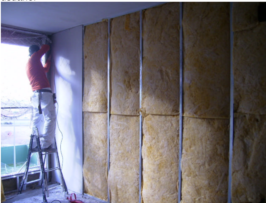
Foto 15: Ejecución de divisorios de PYL entre distinto usuario.
