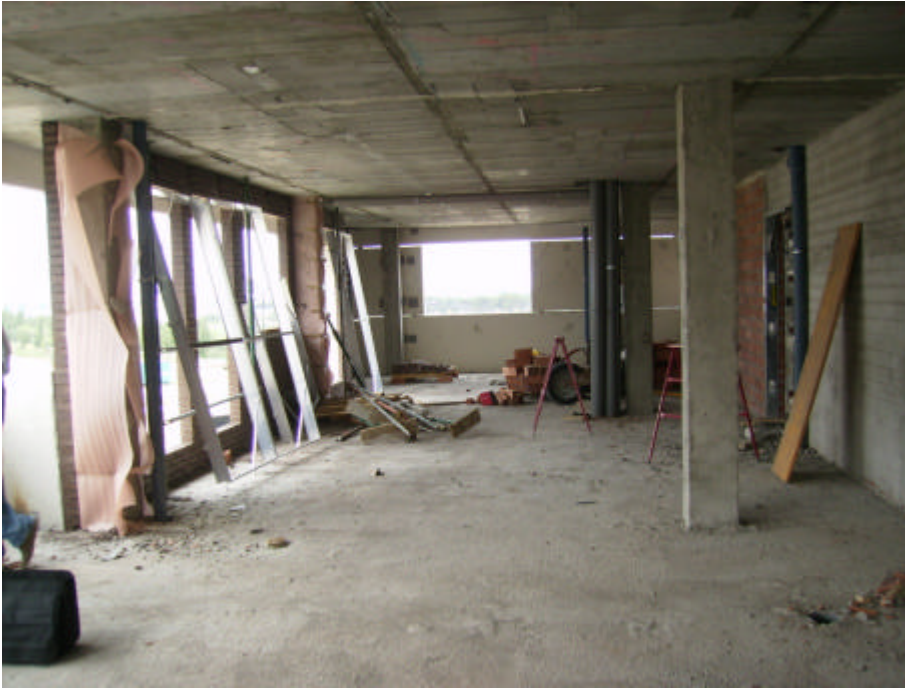
Vista de la planta diáfana antes de ejecutar los cerramientos de las viviendas.
