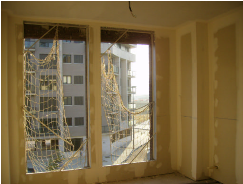
Foto 18: Acabados en PYL de los recintos.
