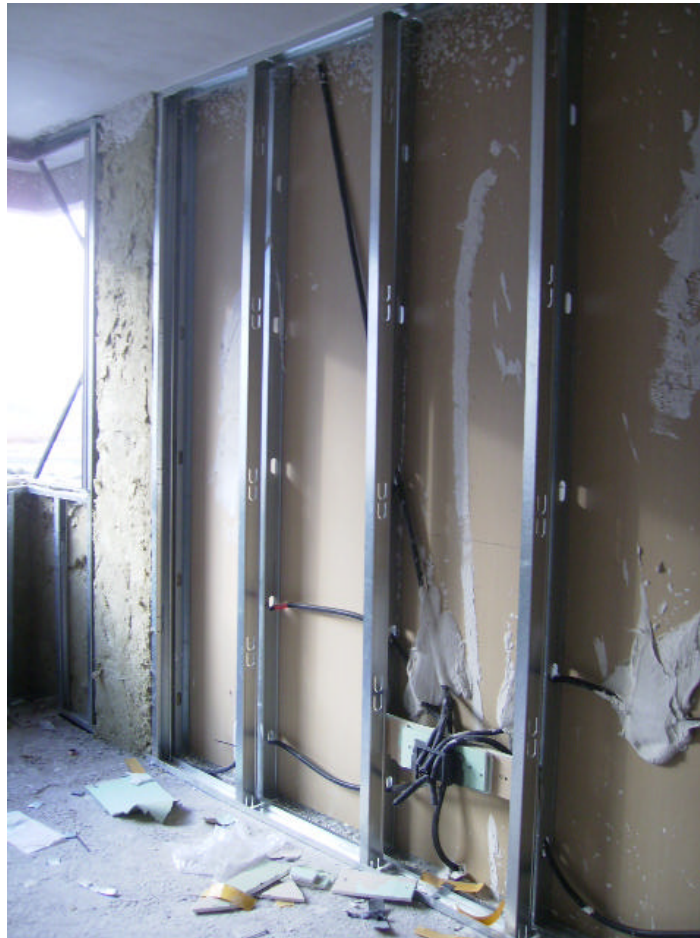
Foto 14: Preparación de la perfilería para divisiones en PYL de distinto usuario.
