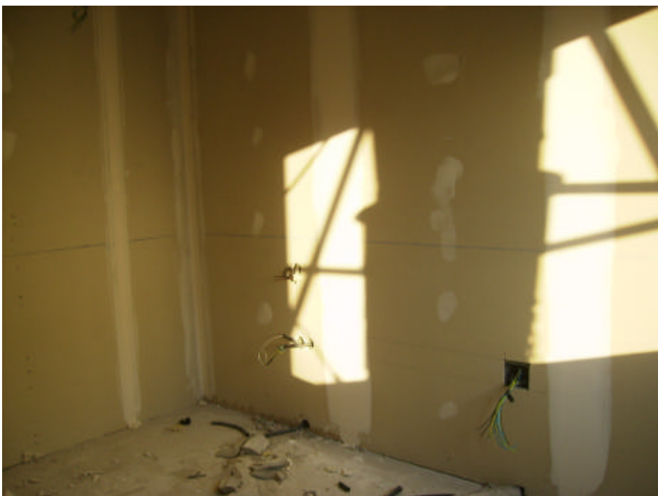
Foto 17: Acabados en PYL de los recintos.
