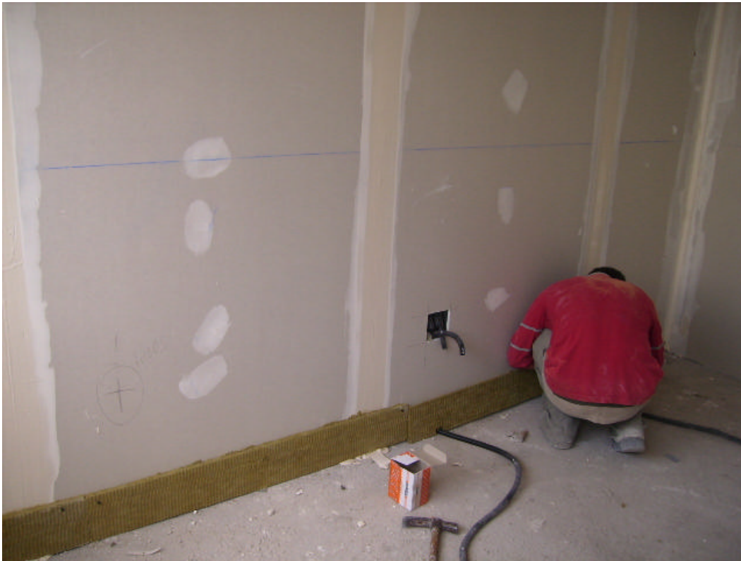
Foto 20: Preparación de suelos para suelo flotante. Colocación de la lana mineral.
