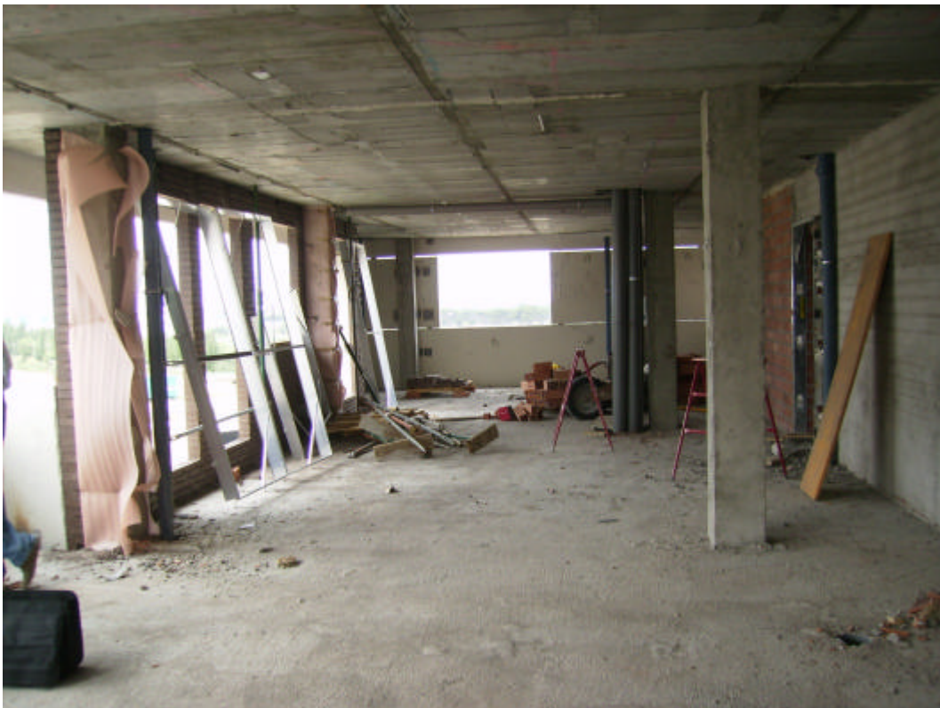
Foto 3: Detalle de las plantas diáfanas antes de ejecutar los sistemas.
