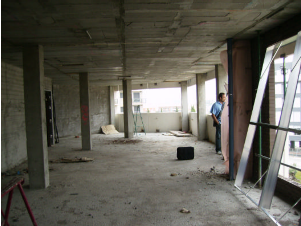
Foto 2: Detalle de las plantas diáfanas antes de ejecutar los sistemas.
