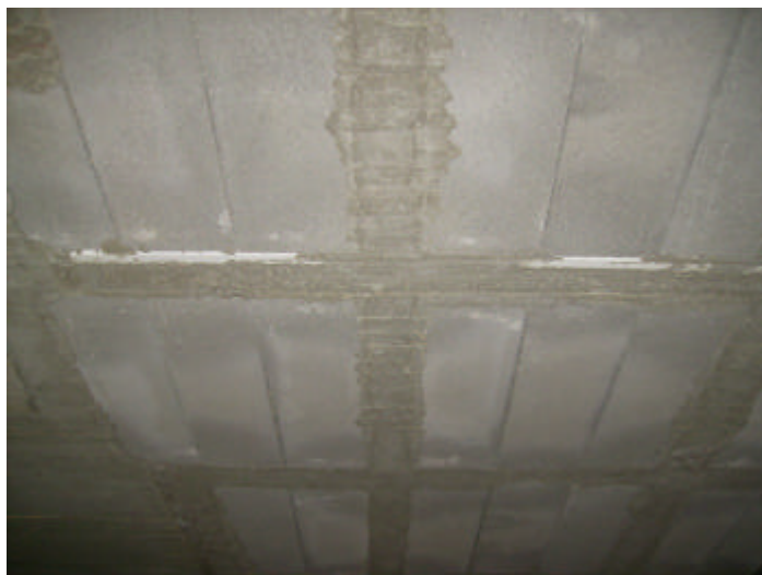
Detalle de la parte inferior del techo de los recintos.
