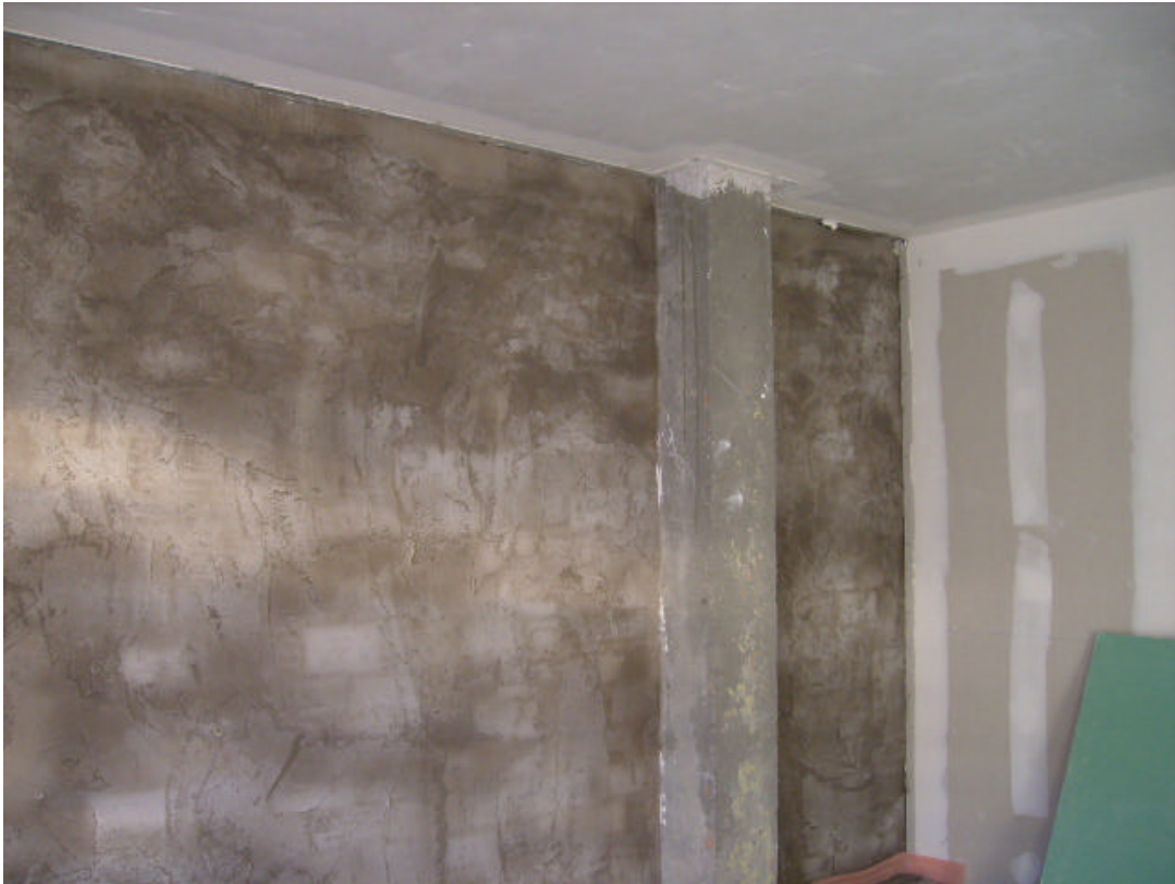
Foto 8: Tabique de ladrillo hueco doble enfoscado como elemento base para separación entre recintos de distinto usuario.
