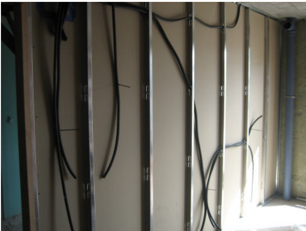
Foto 13: Preparación de la perfilería para divisiones en PYL de distinto usuario.
