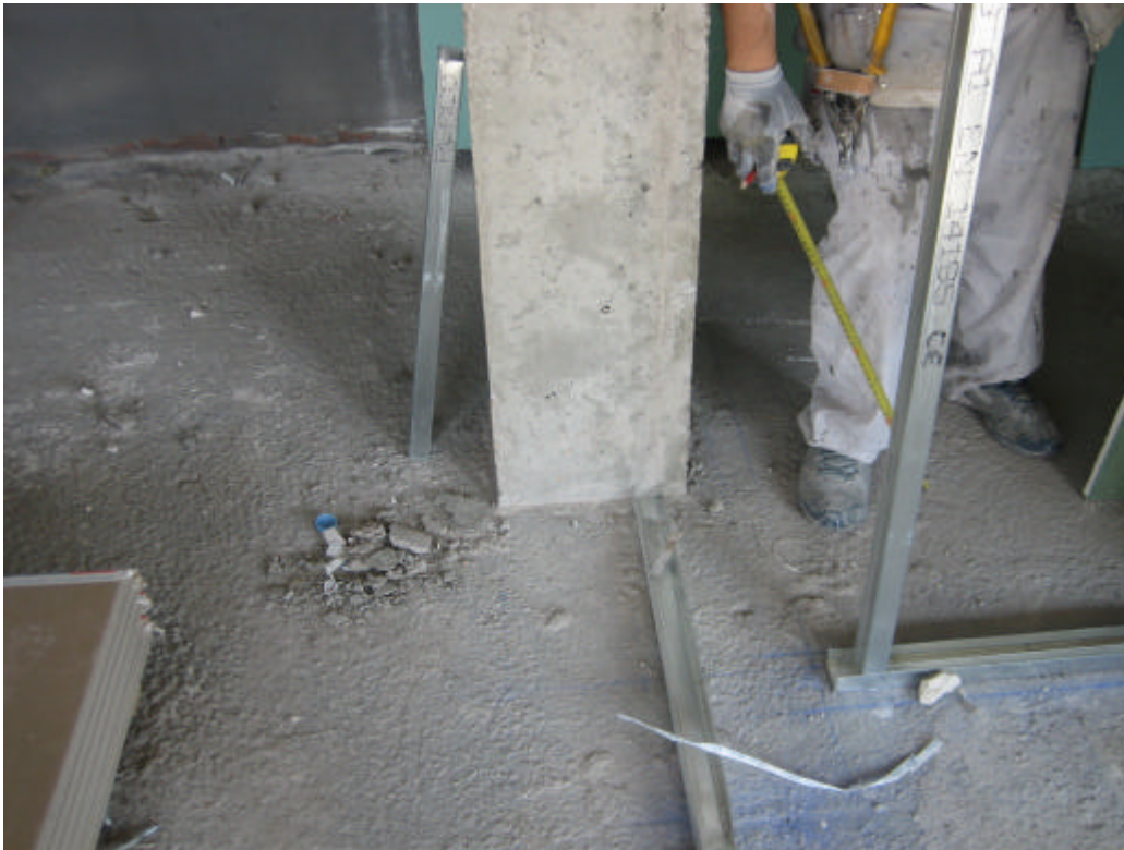
Foto 12: Preparación de la perfilería para divisiones en PYL de distinto usuario.
