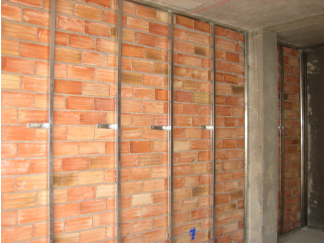
Foto 10: Preparación de la perfilería sobre tabique de ladrillo hueco doble.
