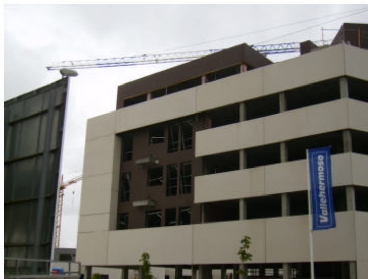
Vista exterior del edificio
