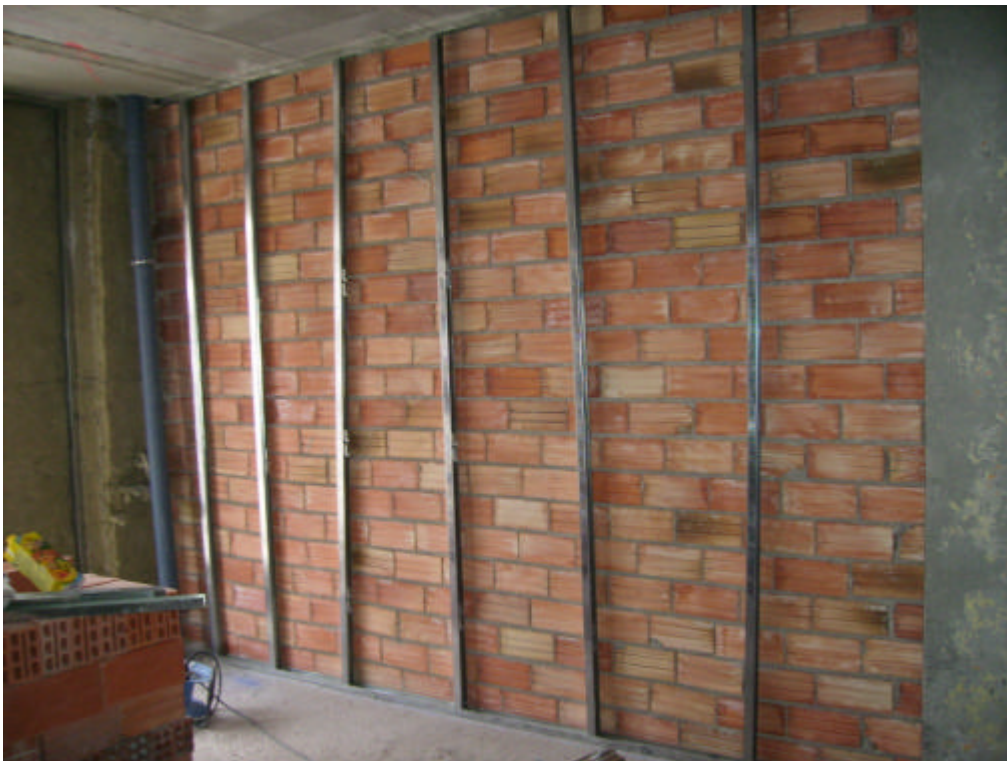
Foto 9: Preparación de la perfilería sobre tabique de ladrillo hueco doble.
