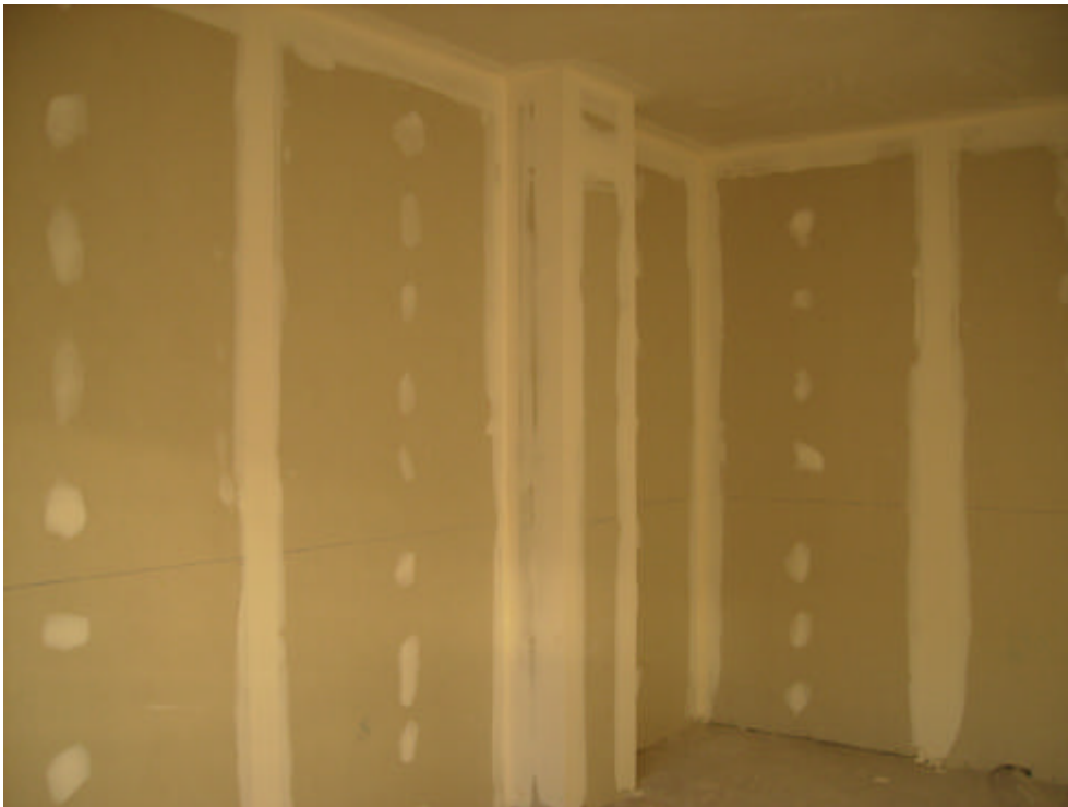
Foto 19: Acabados en PYL de los recintos.
