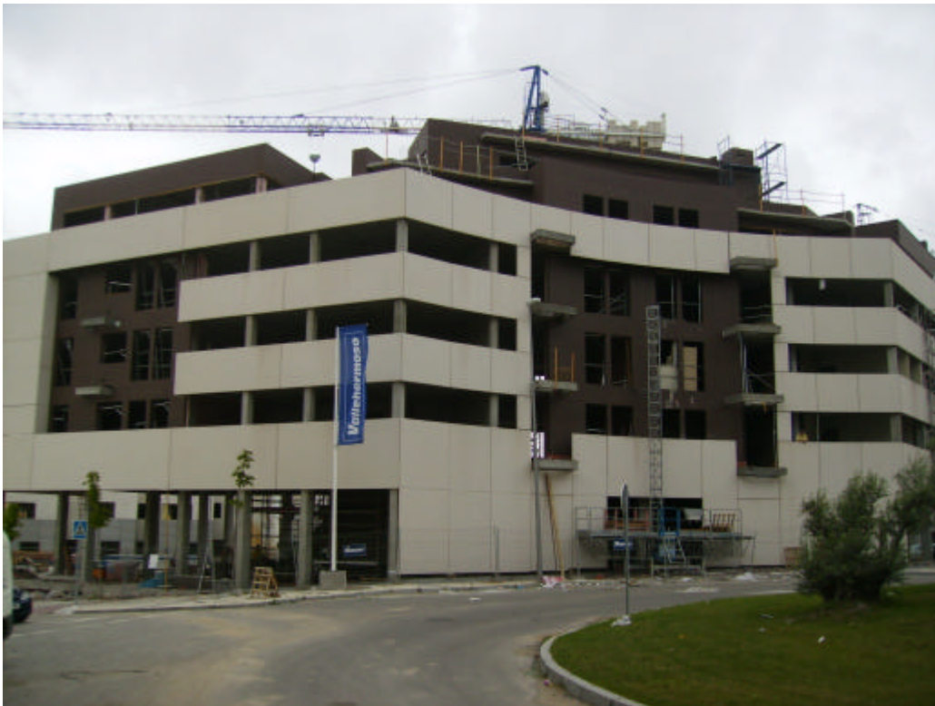
Foto 1. Edificio donde se llevaron a cabo los ensayos.
