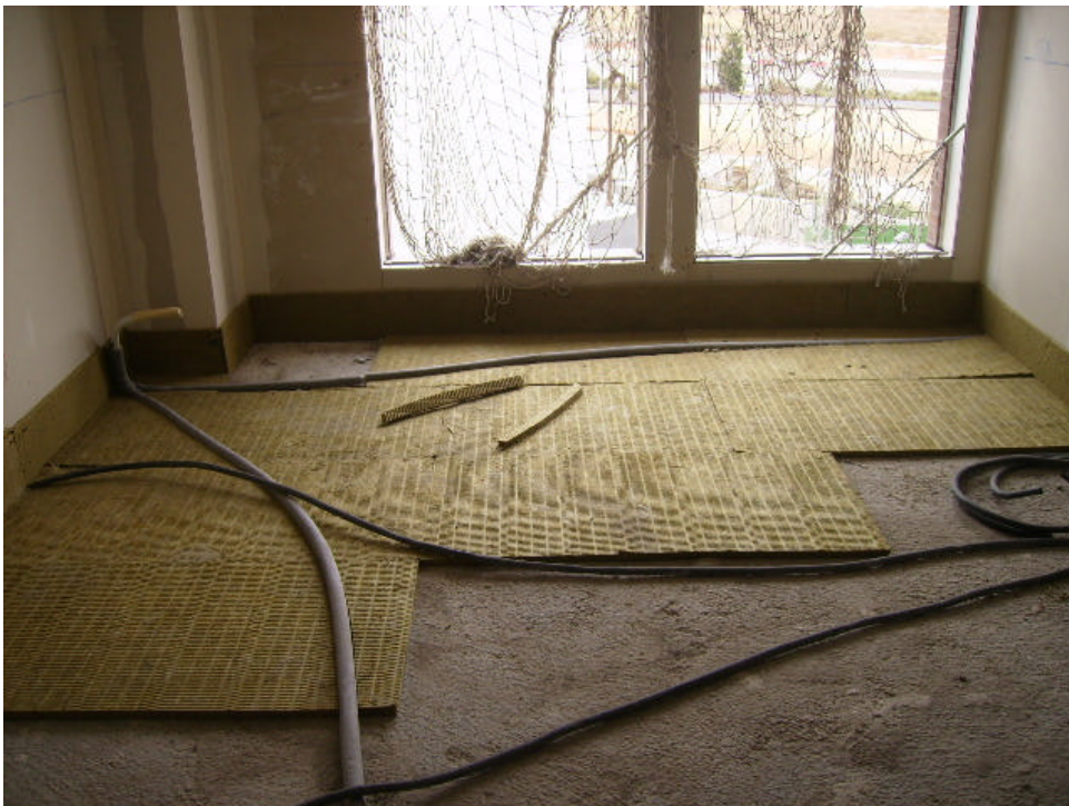
Foto 21: Preparación de suelos para suelo flotante. Colocación de la lana mineral.
